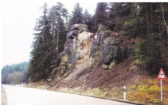
Situation am Felsen nach der Sprengung
