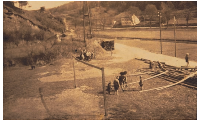
Der Sportplatz bei Alois Lehner in der Bauphase. - Das rechte Tor. (Heute wohnen dort: Stöbl Karl-Heinz, Heigl Hubert usw.)
