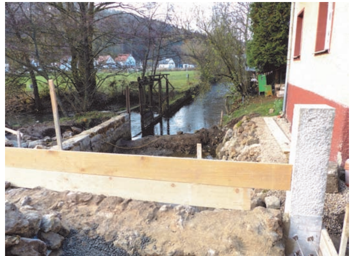
Mit einem Damm am Stauwehr wurde der Triebwerkskanal trockenengelegt
