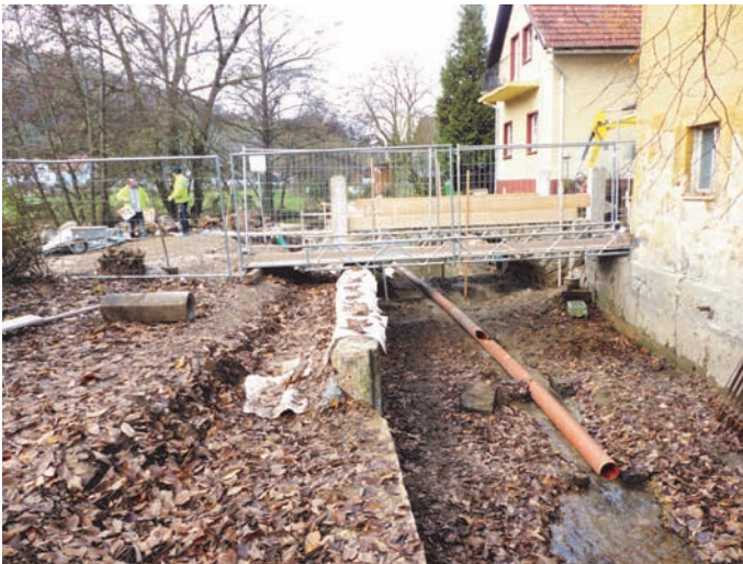
Die Sanierung des Pfistermühlbrückerls schreitet voran, für die Fußgänger und Schulkinder wurde ein Behelfsbrücke errichtet
