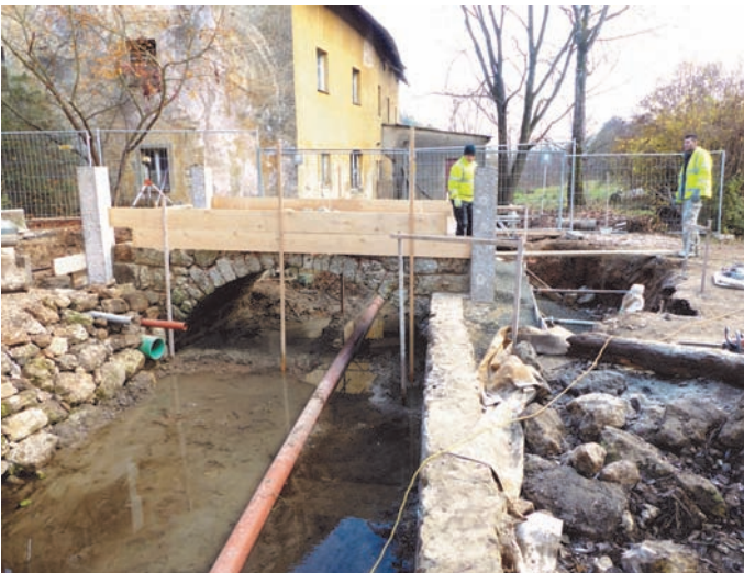
Ein schmales Wasserrohr sorgt dafür, dass der Mühlbach nicht trocken fällt
