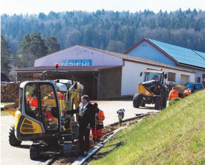
Bürgermeister Stefan Braun (Mitte) erkundigt sich bei den Bauarbeitern immer wieder nach dem Baufortschritt und eventuell auftretenden Schwierigkeiten.
