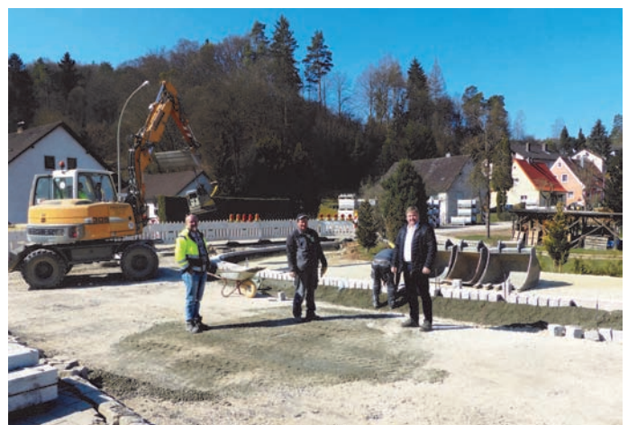
Bürgermeister Stefan Braun (Rechts) befragt, natürlich mit dem notwendigen Abstand, den Polier Thilo Kohlbrand (Mitte) und Bauleiter Florian Gottschalk (Links) von der Fa. Engelhardt nach dem Baufortschritt, nachdem derzeit die Randsteine für die neue Zufahrt gesetzt werden
